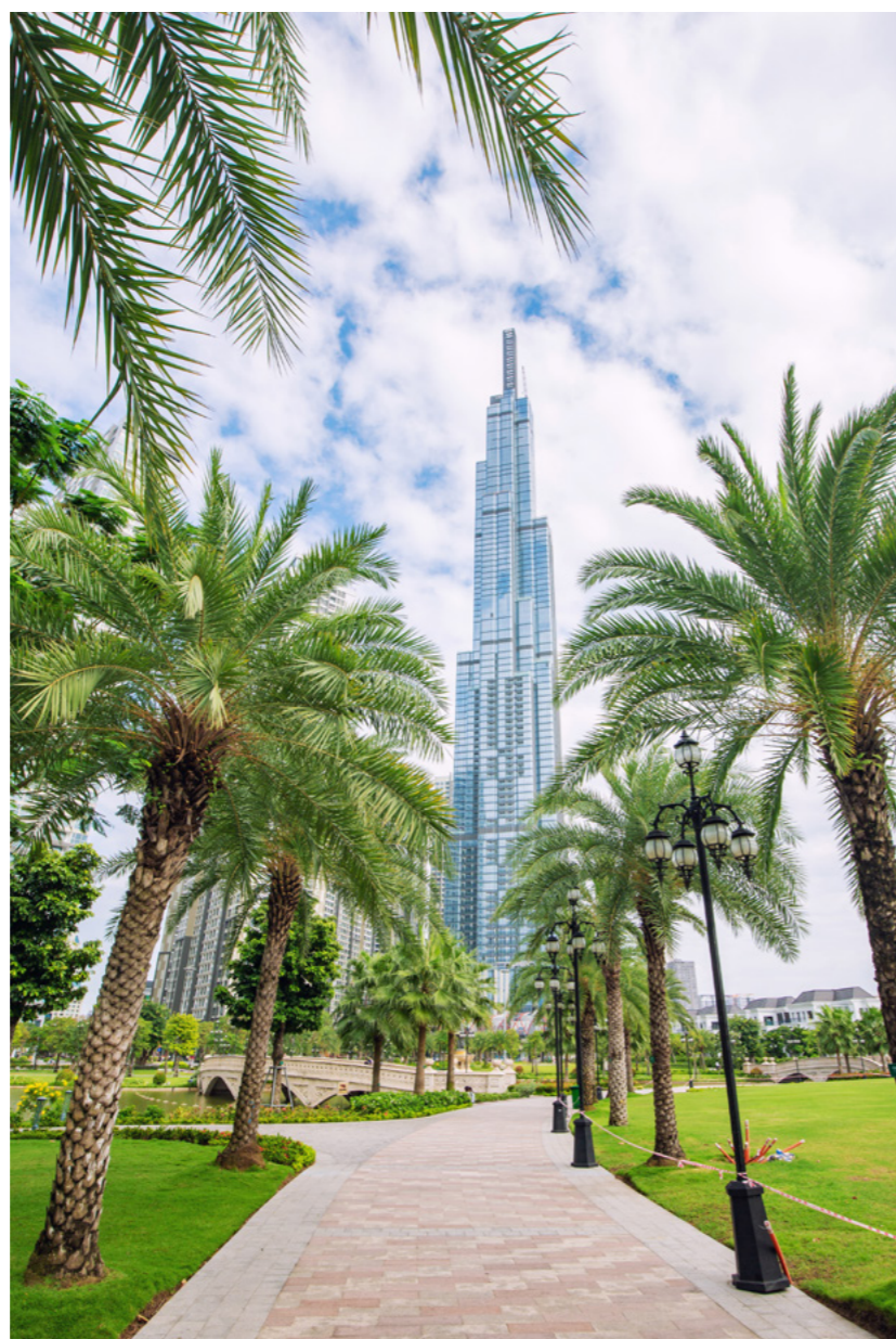
Toà nhà Landmark 81, Thành phố Hồ Chí Minh
